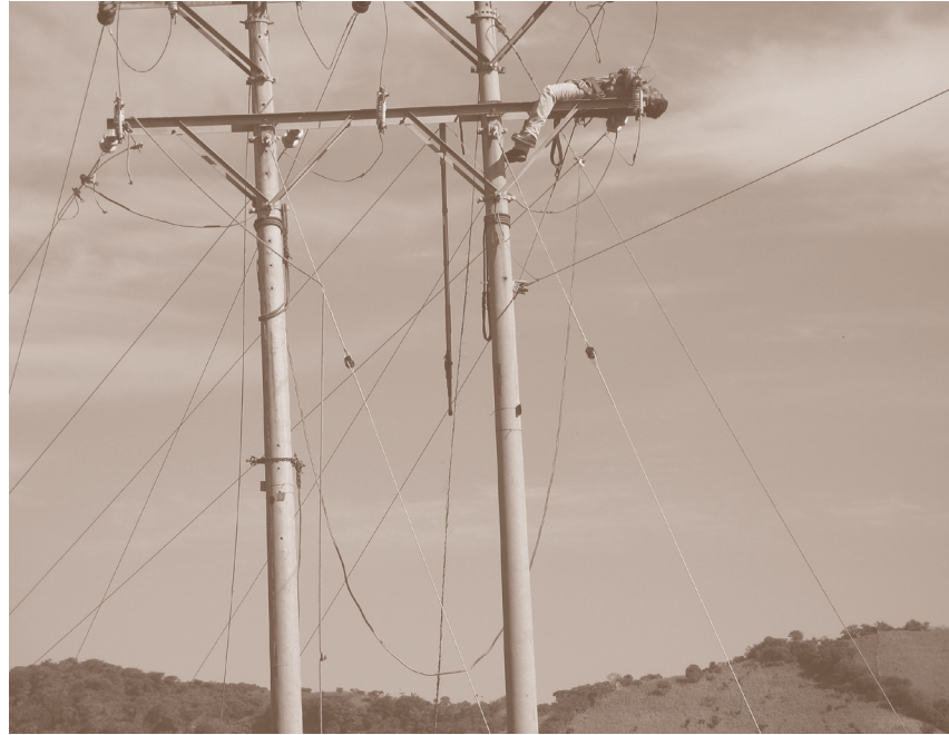
Trabajador eléctrico subcontratado en El Salvador, 20 de mayo de 2007.
